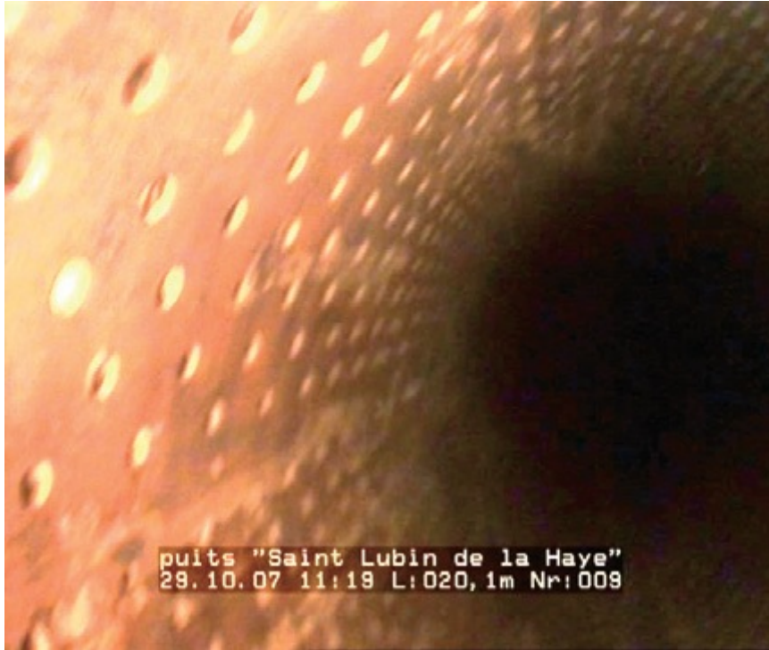
Captage de l'eau au fond d'un puits
